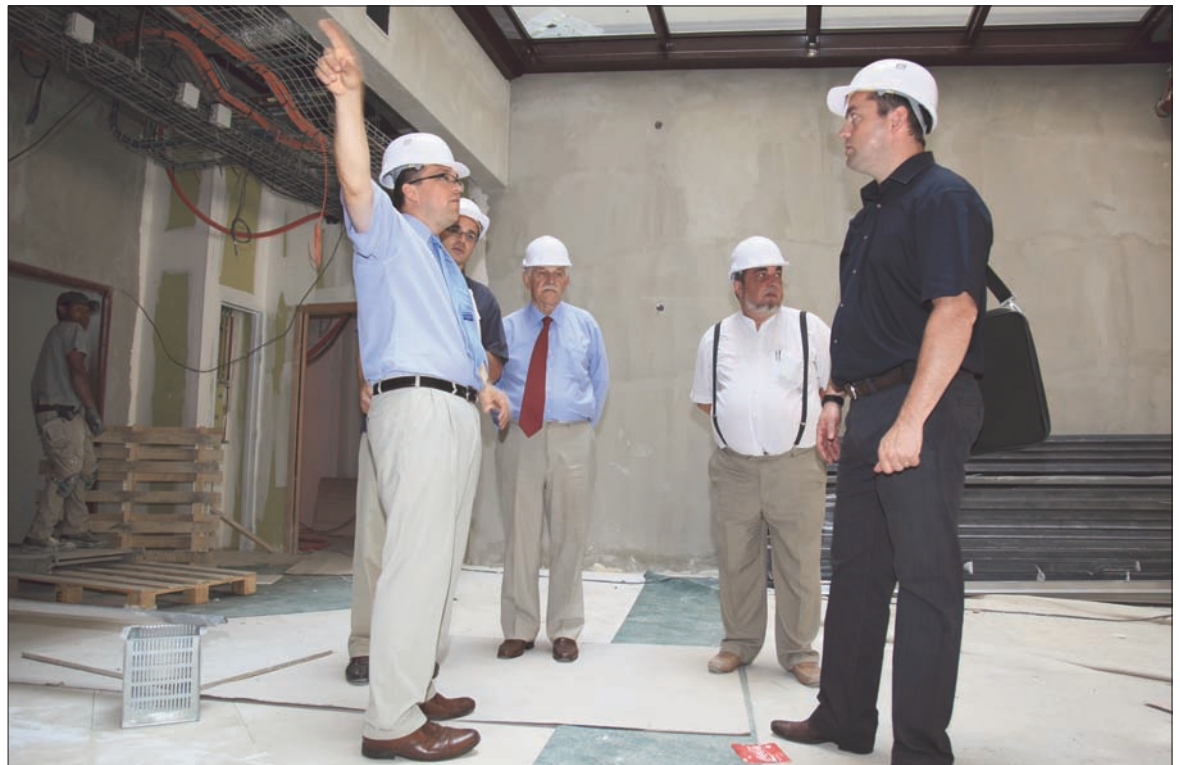
Pour que la nouvelle clinique puisse ouvrir dans le courant du mois de septembre, le chantier mobilise jusqu'à 150 personnes par jour sous l'oeil attentif de Jean-Pierre et Thierry Liégeois (à gauche) et Thierry Le Guyader, l'architecte du projet.
