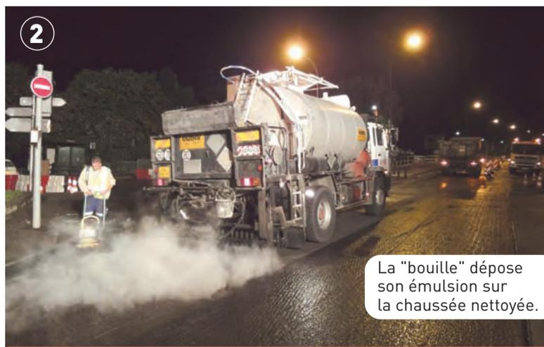
La "bouille" dépose son émulsion sur la chaussée nettoyée.
