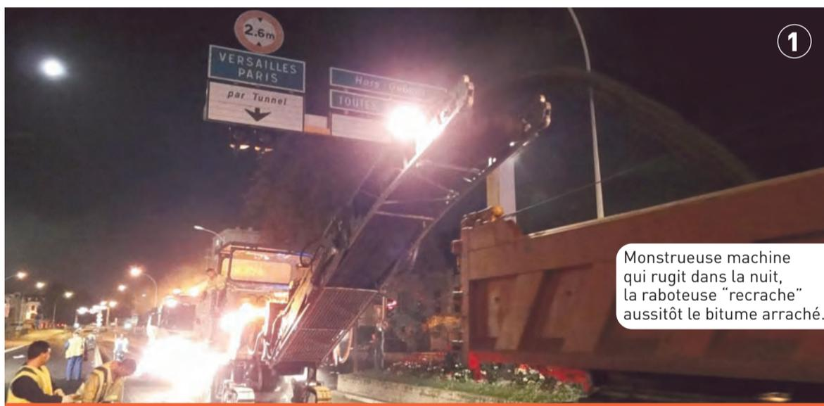
Monstrueuse machine qui rugit dans la nuit, la raboteuse "recrache" aussitôt le bitume arraché.
