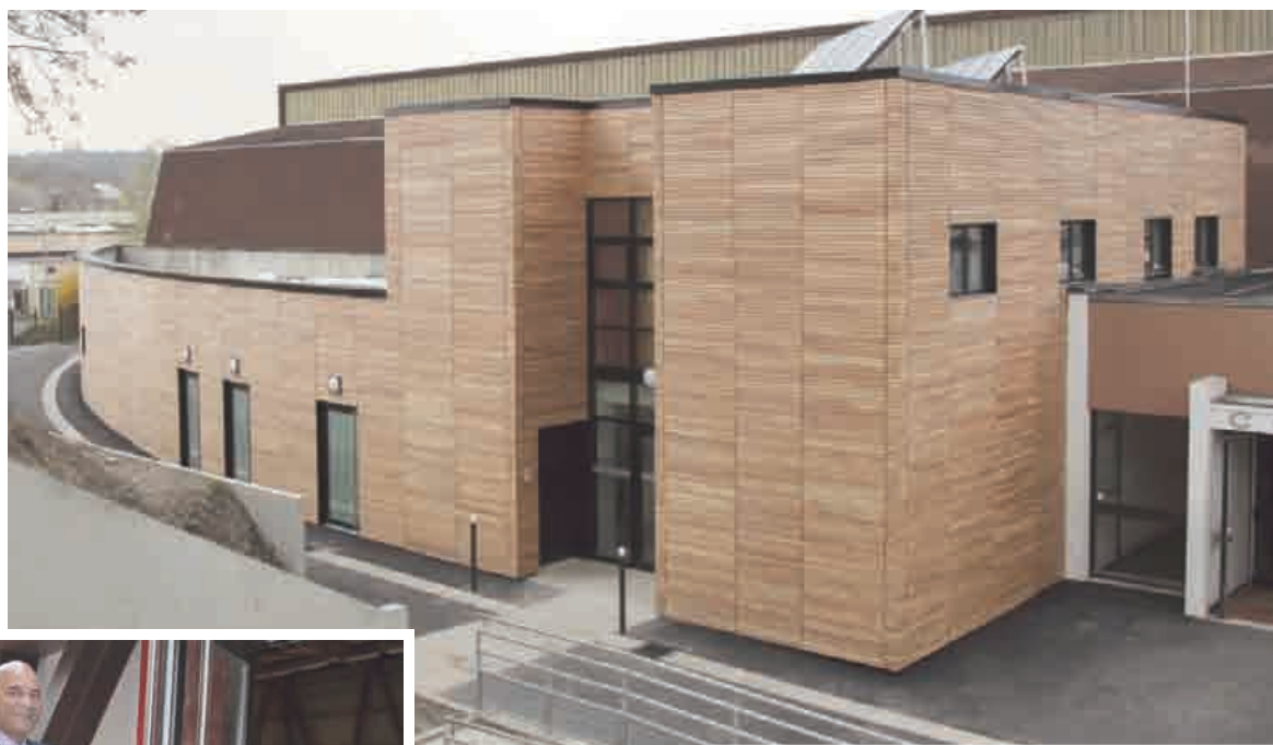
Les façades en bois d'acacia et la toiture végétalisée vont améliorer l'isolation du nouveau bâtiment.
