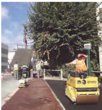
Les travaux rue Saint-Léger
