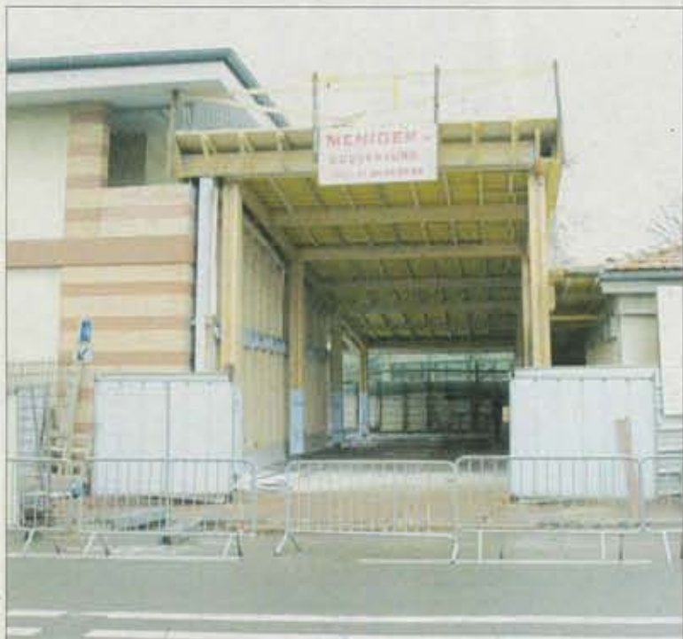
L'extension du restaurant élémentaire de l'école Ampère progresse; la charpente est posée et les travaux de couverture sont commencés.
