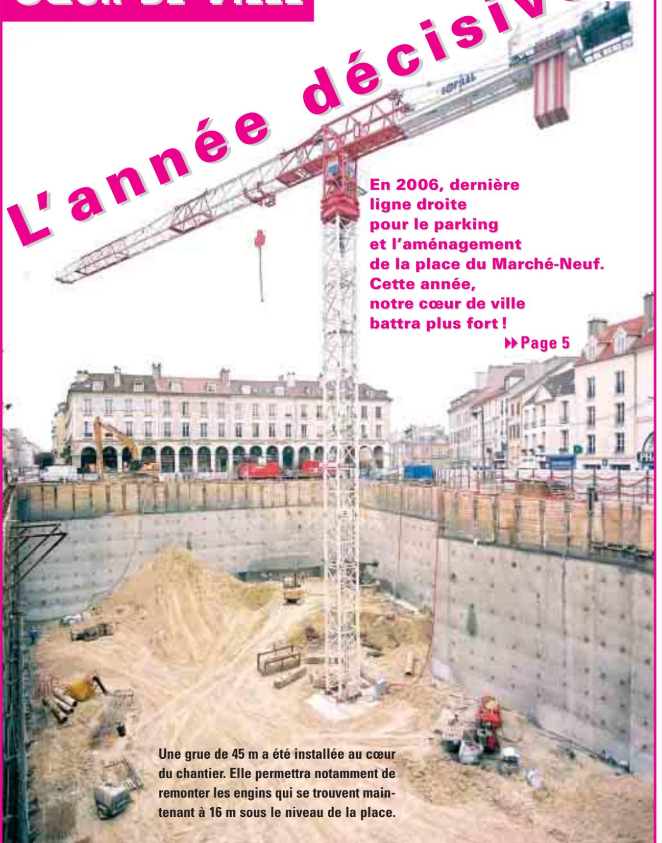
Une grue de 45 m a été installée au cœur du chantier. Elle permettra notamment de remonter les engins qui se trouvent maintenant à 16 m sous le niveau de la place.
