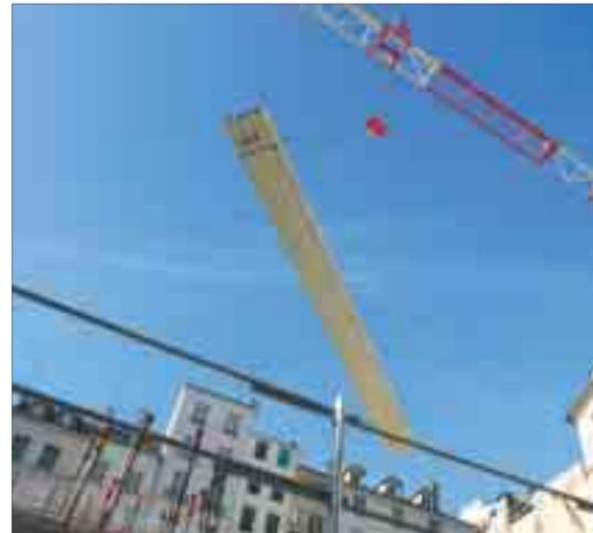
Les dalles alvéolaires sont préfabriquées et arrivent par camion sur le chantier. Elles sont descendues à l'aide de la grue.
