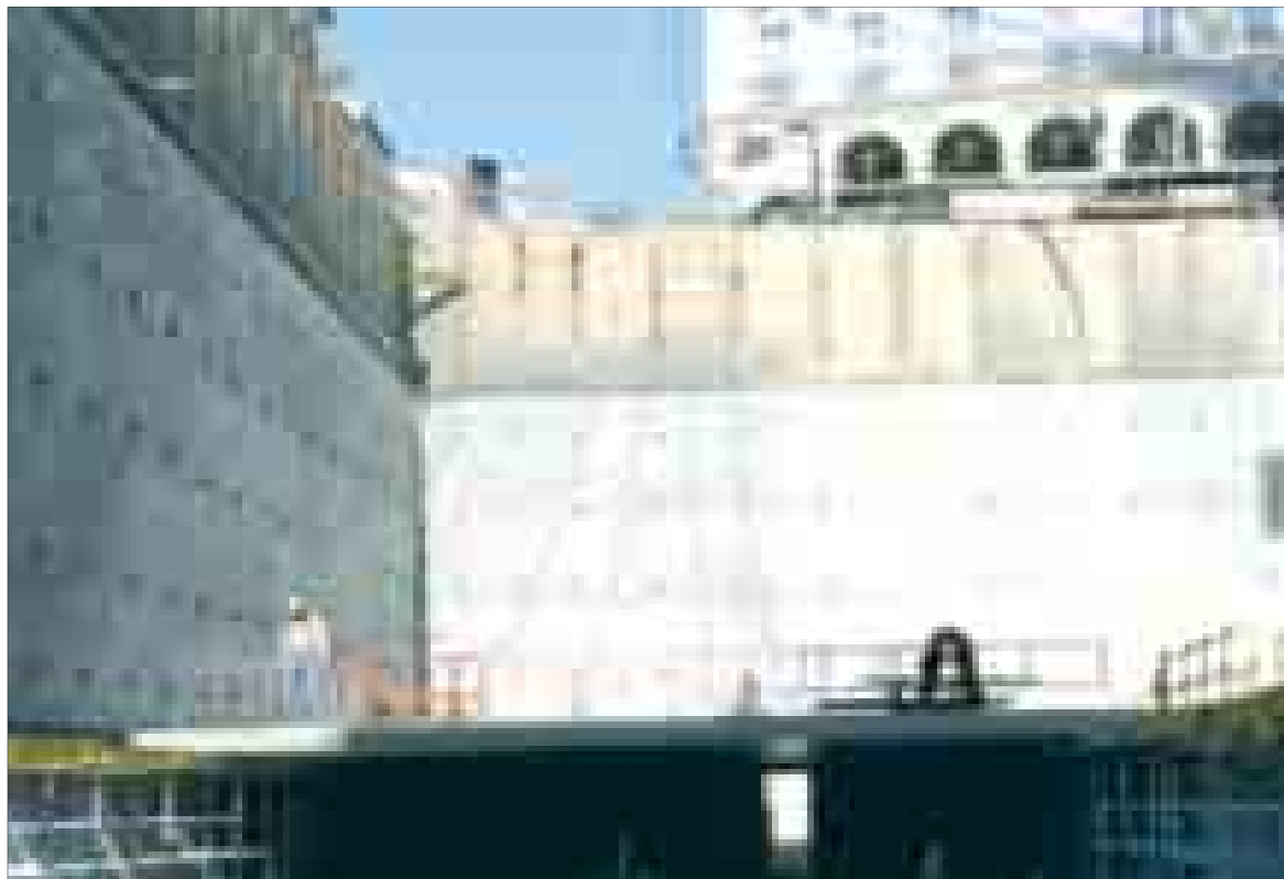
La construction du cinquième et dernier niveau du parking, où quatre-vingt-dix places sont à vendre, s'est achevée il y a quelques jours.
