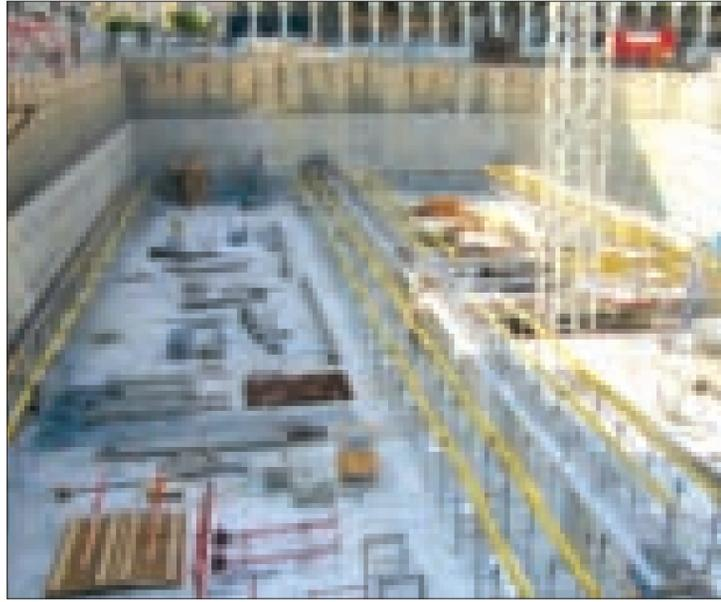
Tout est prêt pour accueillir le "plafond" du troisième niveau. Le recours à des éléments fabriqués en dehors du chantier permet de limiter les nuisances et de faciliter l'assemblage.
