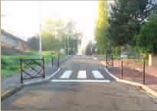
PROTÉGER LES ENFANTS. - Deux avancées de trottoir boulevard Hector-Berlioz avec matérialisation du passage pour piétons et mise en place de barrières.
