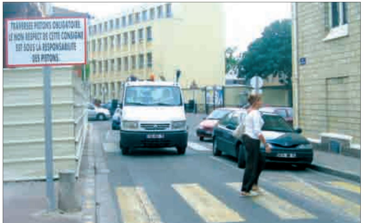
Rue d'Ourches, aux abords de la place Lamant et du chantier du futur centre de radiothérapie de l'hôpital, un panneau invite les piétons à changer de trottoir pour contourner les palissades.
