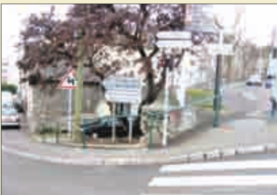
AIDER LES PIÉTONS. - À l'angle de l'avenue Général-Leclerc et de la rue de l'Ermitage, sur le trottoir, implantation d'une main courante sur 20 mètres.
