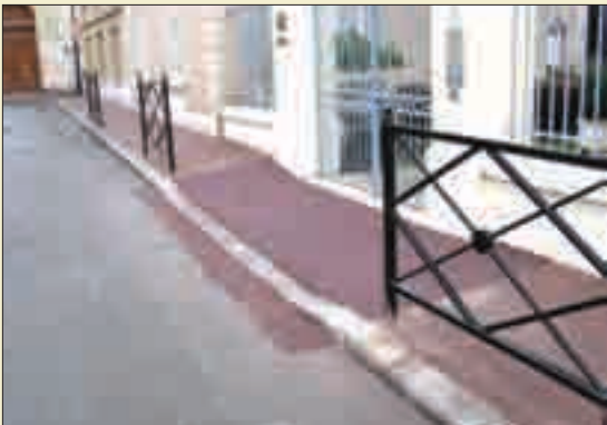
FACILITER LES DÉPLACEMENTS. - Rue de Tourville, abaissement uniforme des bordures du trottoir pour les personnes à mobilité réduite.
