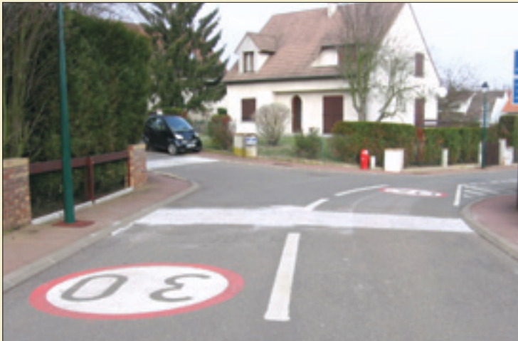
RENFORCER LA SIGNALISATION. - Meilleure signalisation au sol de la zone 30 par application de bandes pavées, rue des Panlous et allée des Noisetiers.
