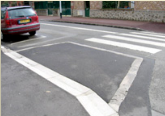
POUR LES PIÉTONS. - Devant certains passages pour piétons, création "d'oreilles" et abaissement des bordures de trottoirs.
