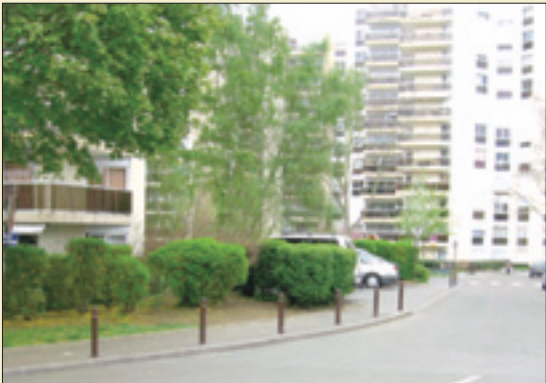
LUTTER CONTRE LE STATIONNEMENT ANARCHIQUE. - Mise en place de potelets sur le trottoir de la rue Rossini, au Bel-Air.
