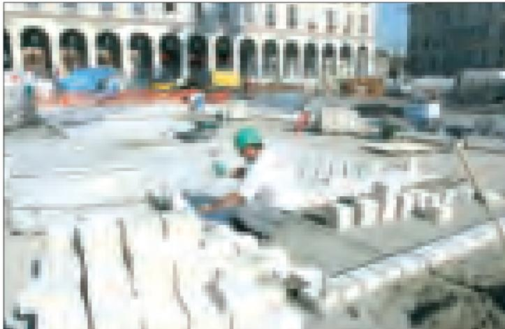
Notre nouvelle place prend forme. Le dallage de pierres calcaire de Croatie est en cours d'installation.
