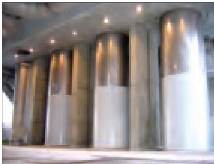
La nouvelle unité de traitement des pollutions azotées est actuellement mise en service à Saint-Germain-en-Laye. Notre photo : quelques-unes des énormes canalisations aspirant les eaux usées jusqu'aux bassins de nitrification.
