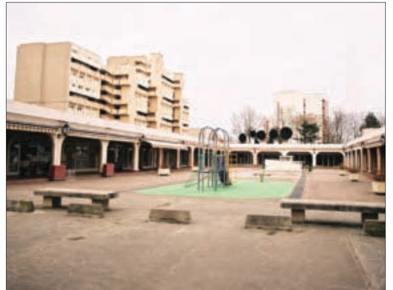
Fruit d'une conception architecturale d'une autre époque, la dalle du centre commercial du Bel-Air sera réaménagée conformément aux vœux de la Ville et des habitants du quartier.
