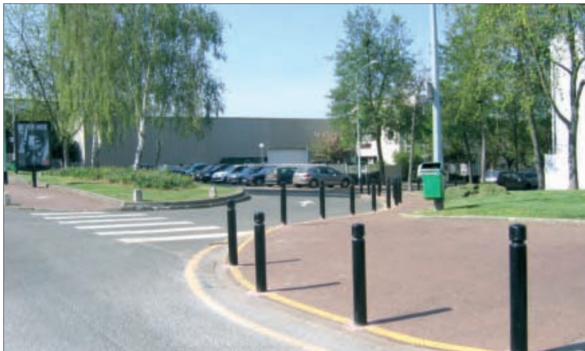
Pour éviter le stationnement anarchique sur les trottoirs aux abords du carrefour entre les rues Saint-Vincent et Saint-Éloi, le service municipal de la Voirie a mis en place des potelets sur les trottoirs.
