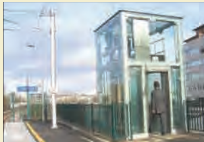
Victimes de nombreuses dégradations intentionnelles, l'ascenseur de la gare Saint-Germain/Bel-Air enfin en marche !
