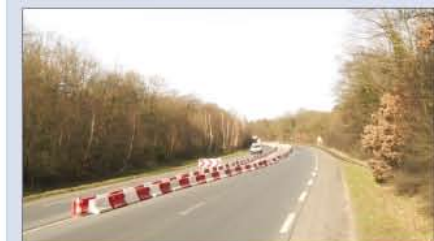
Sur la RN 184, la mise en place d'îlots centraux et de plots réfléchissants, et la refonte de la signalisation horizontale entre le carrefour de la Croix de Noailles et le Foyer du Grand Cormier sont déjà en cours.
