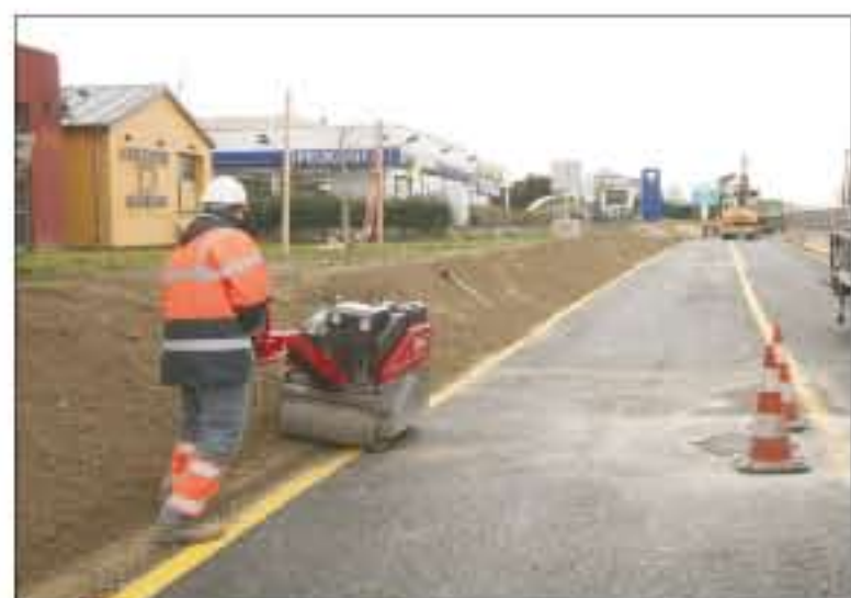
Sur la RN13, la SAPN aménage actuellement une chaussée provisoire pour dévier le trafic sur plusieurs dizaines de mètres aux abords du carrefour du Chemin-Neuf, où le souterrain à la bretelle d'accès à l'échangeur de l'A14 sera creusé.
