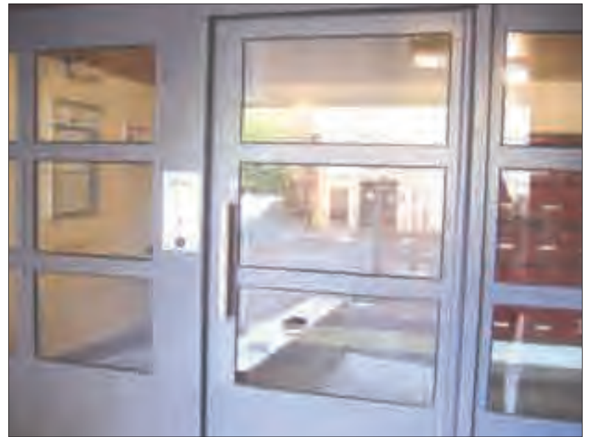
Les travaux de rénovation des logements des "3F" au Bel-Air ont déjà permis la sécurisation des halls d'entrée.
