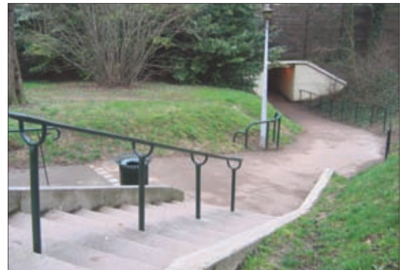
La rampe qui a été installée entre la rue Raymond-Vidal et le souterrain de la RN13 limite les risques de glissade.
