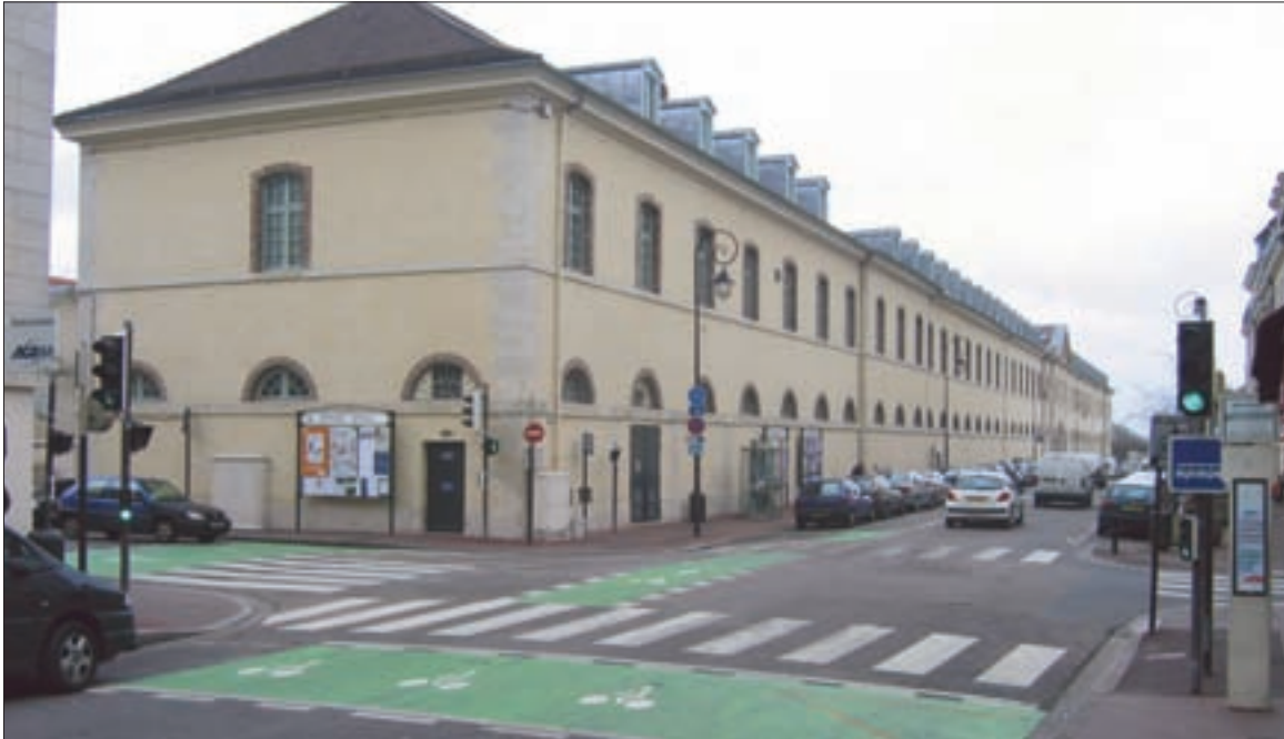
Pour renforcer la sécurité des cyclistes au carrefour des rues de Paris et Maréchal-Lyautey, un “sas cyclable” a été créé entre la ligne d'arrêt des véhicules aux feux de signalisation et les passages piétons.
