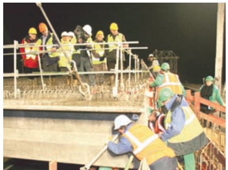
Les poutres de 22 m de long et de 22 tonnes ont été déposées "au millimètre près" sur le futur échangeur de l'A14 par une énorme grue.
