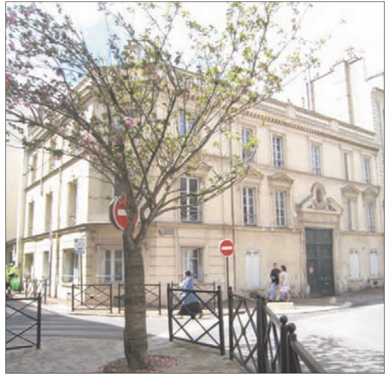
Le bâtiment de la rue des Écuyers, qui appartient aujourd'hui à GDF, devrait devenir demain une crèche de 50 à 60 places.
