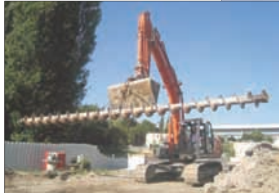
233 "trous" vont être forés jusqu'à 25 m sous terre.
