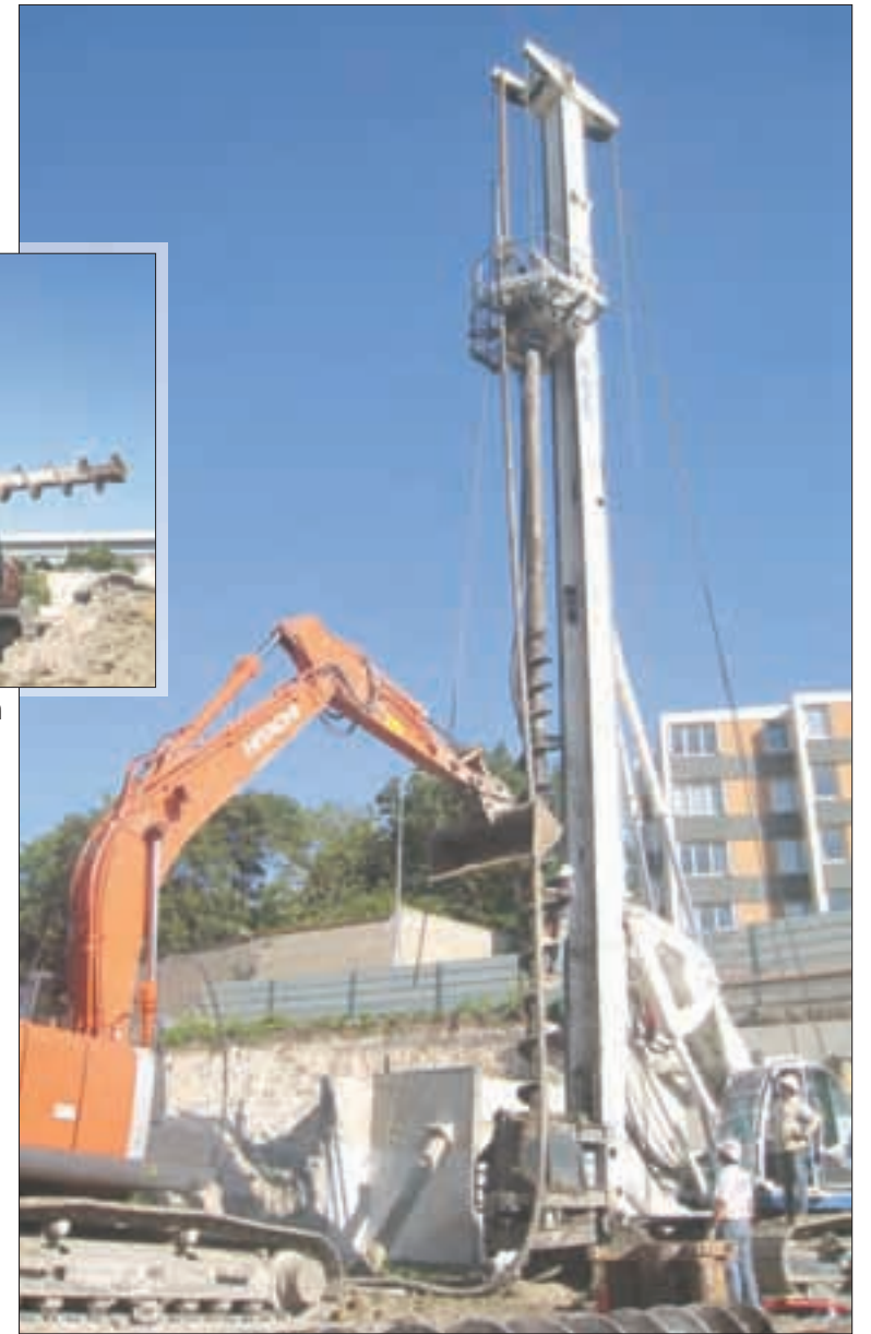
Pour creuser le "nid" des pieux en béton armé, Bouygues utilise une foreuse de 25 m de haut.
