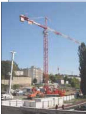
Sur le chantier du Parc de la Maison Verte, une grue géante vient de rejoindre la foreuse de 25m qui est utilisée pour implanter des pieux en béton armé de 20 ou 25 mètres nécessaires aux fondations profondes des futurs bâtiments. Ce terrain, situé à l'angle de la rue Saint-Léger et de la rue des Lavandières, accueillera 100 logements locatifs sociaux, des logements en accession libre à la propriété et des logements en accession à la propriété à coût maîtrisé.
