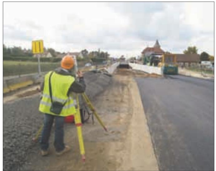
Aux abords du souterrain creusé à proximité du carrefour du Chemin-Neuf pour relier directement la RN13 à la bretelle de raccordement de l'échangeur de l'A14, les premiers enrobés ont déjà été coulés. Pour les réaliser, il a fallu évacuer 1200 tonnes de terre qui sont notamment réutilisées pour assurer l'intégration de la bretelle de raccordement à l'échangeur dans son environnement.
