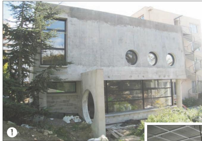
"Pour que l'isolation acoustique du nouveau studio de répétition/enregistrement soit parfaite, il est construit sur une dalle à ressorts et possède des murs qui sont indépendants de la structure selon le principe de "la boîte dans la boîte", souligne Noël Carat.
