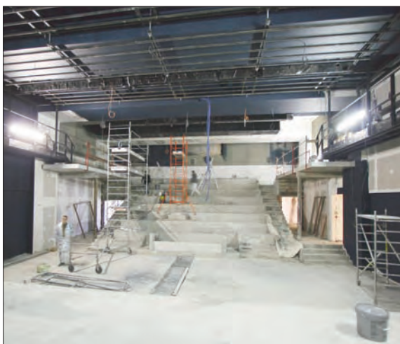
L'ancienne salle des Amitiés Internationales a été agrandie (le sol a été creusé et les murs extérieurs repoussés). Elle pourra accueillir cinq cents spectateurs.
