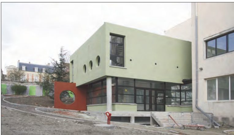
Du côté du jardin, à l'arrière du bâtiment, la façade de l'extension a déjà reçu ses couleurs définitives. Les cheminements piétonniers qui permettront d'y accéder ont été tracés.
