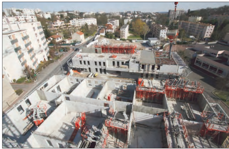
Depuis la pose de la première pierre, le 8 octobre dernier, les travaux du projet immobilier du Parc de la Maison Verte ont bien avancé.
