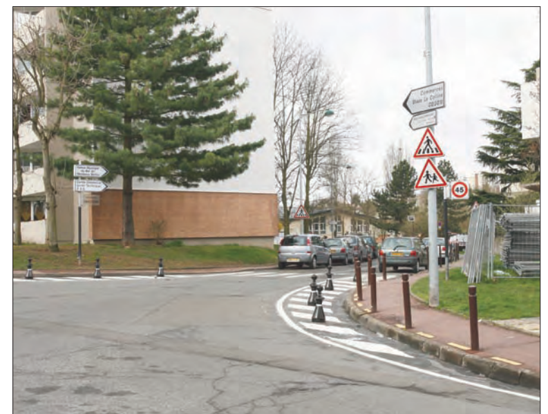
Jusqu'à la pose d'une dizaine de bornes, fin mars, le boulevard Charles-Gounod était fréquemment soumis au stationnement intempestif des voitures sur ses trottoirs.
