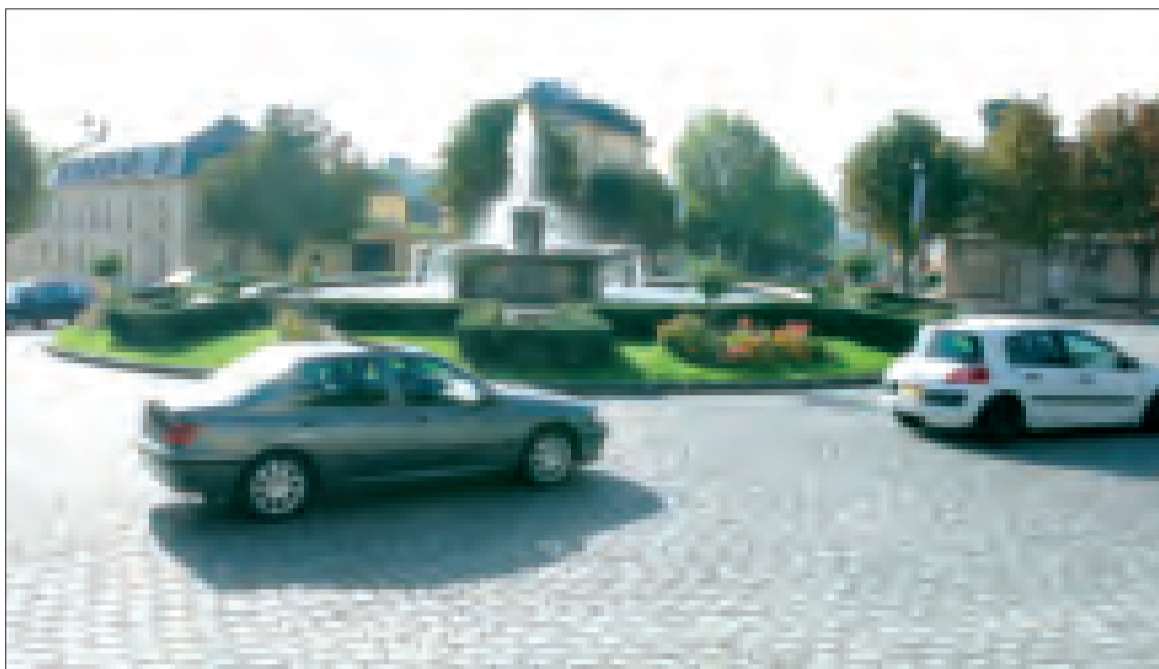
Les travaux de réfection de la place Royale, qui ont eu lieu du 19 juin au 2 septembre, se sont achevés juste avant la rentrée scolaire.
