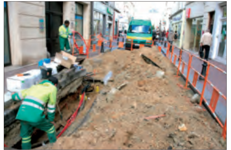
La circulation à l'entrée de la rue de Paris a été interrompue par les travaux de réparation, du dimanche 19 au lundi 20 novembre en milieu de journée.
