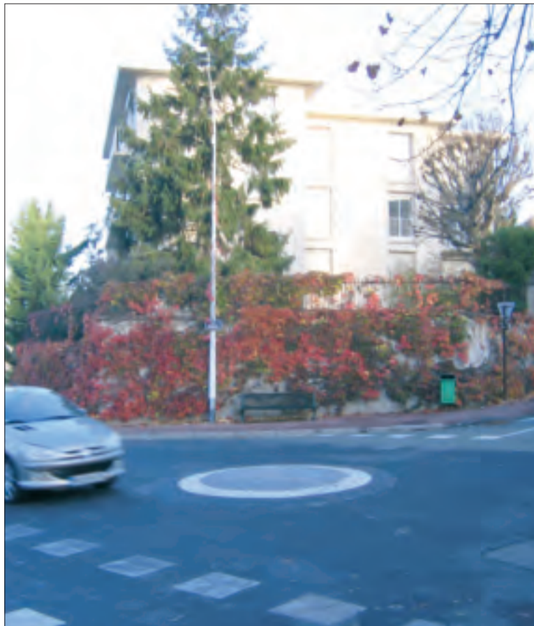
Pour ralentir la vitesse des automobilistes, un dôme pavé a été installé à l'intersection de la rue Denis-Diderot et du boulevard Victor-Hugo.
