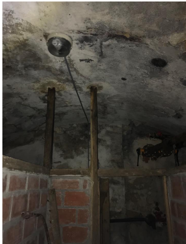
Figure 14 : Vue PH SS-1 - partie voûtée
