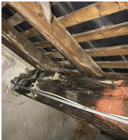
Figure 9 : Vue liteaux-chevrons - charpente
