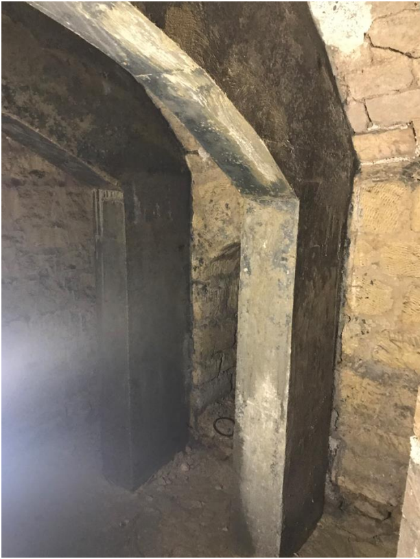
Figure 16 : Vue renforcement BA - galeries souterraines
