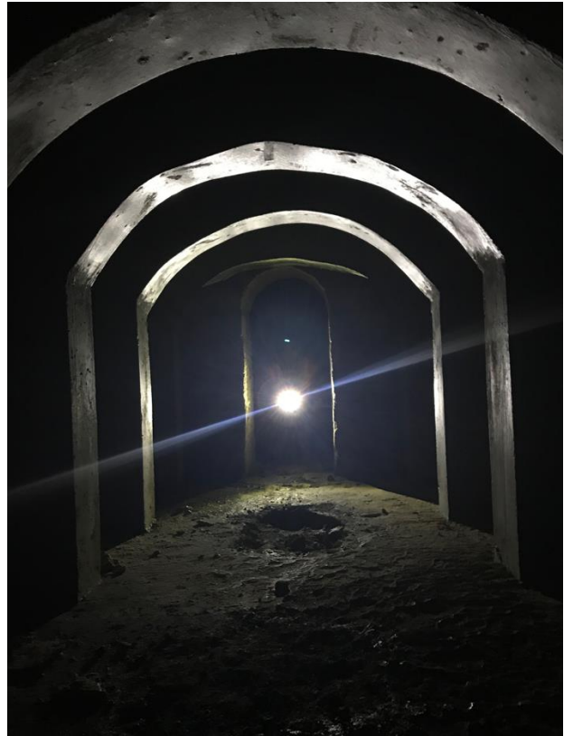
Figure 17 : Vue renforcement BA - galeries souterraines
