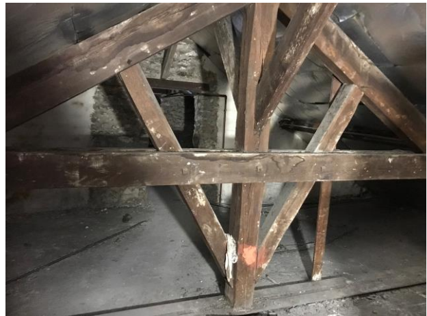
Figure 8 : Vue ferme bois charpente - R+3
