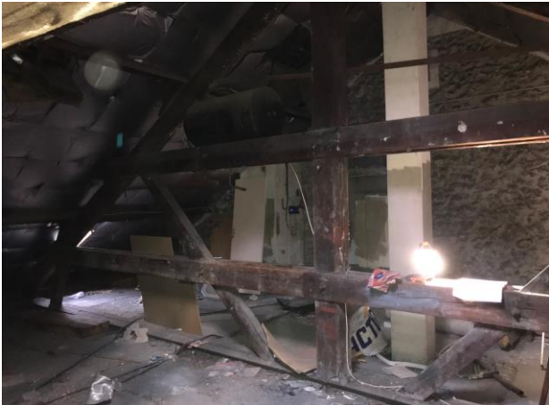
Figure 5 : Vue ferme bois charpente - R+3
