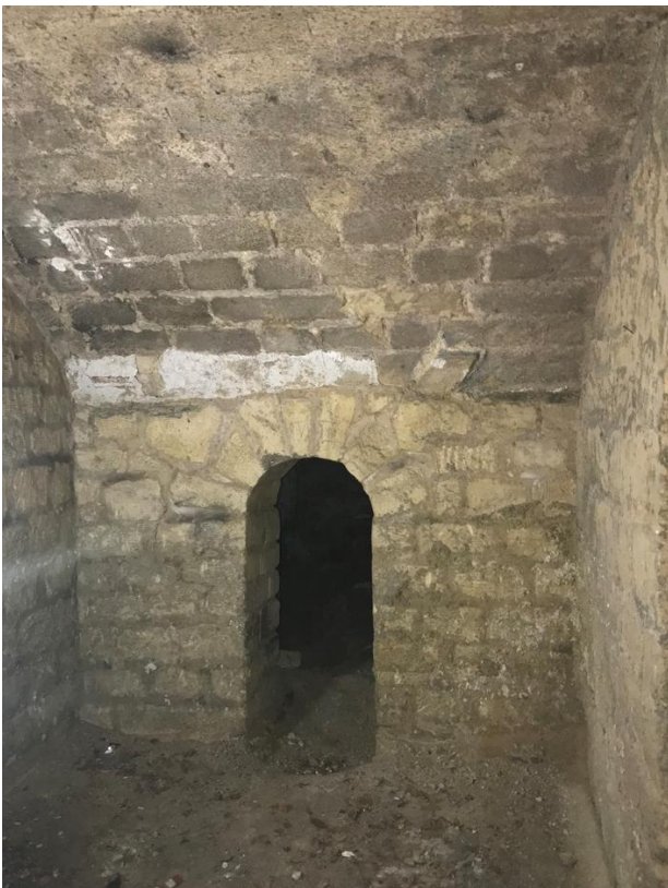
Figure 18 : Vue voûtes - galeries souterraines
