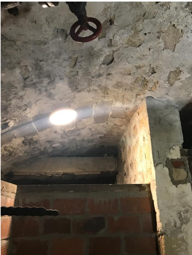
Figure 13 : Vue PH SS-1 - partie voûtée
