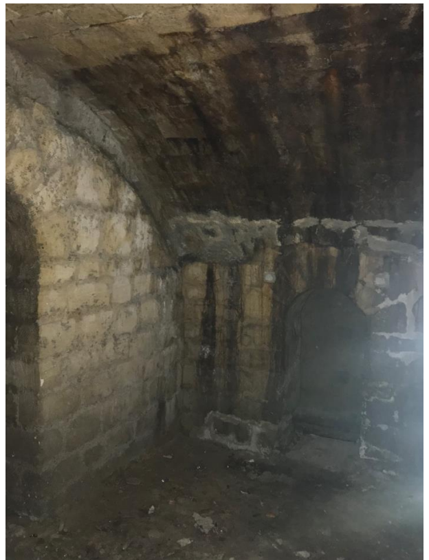
Figure 19 : Vue voûtes - galeries souterraines
