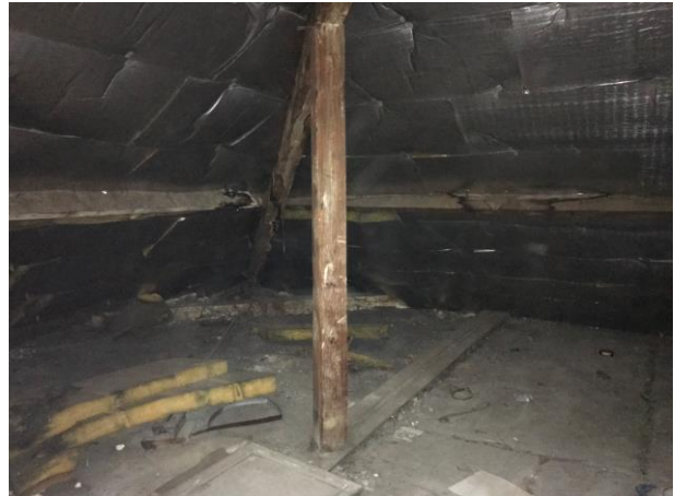
Figure 6 : Vue combles - R+3
