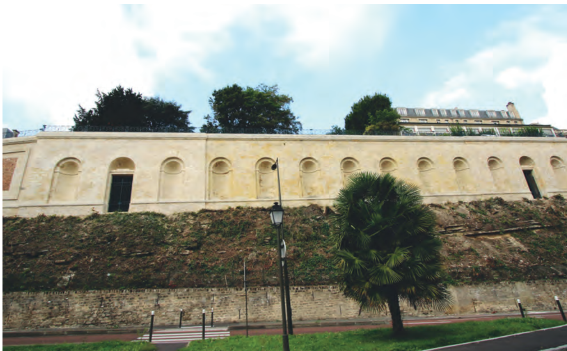
Rampe des Grottes
