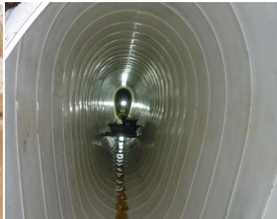
Gainage d'un réseau de type ovoïde (avant / après)
