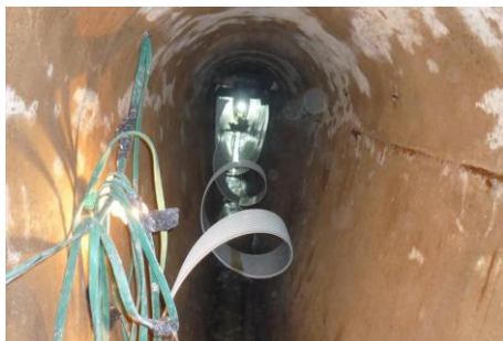
Gainage d'un réseau de type ovoïde (avant / après)
