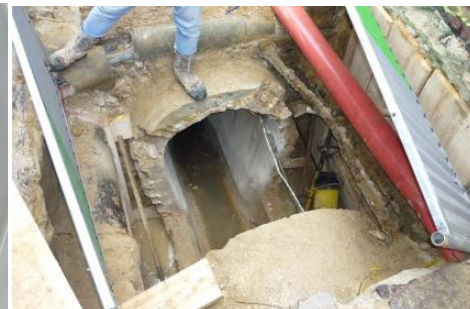
Création d'un regard de visite
