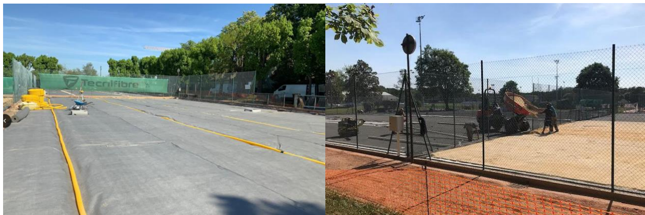
Pendant la rénovation
