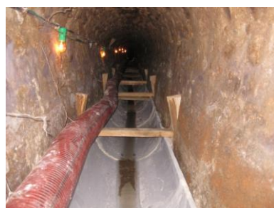
Réhabilitation d'un ovoïde
