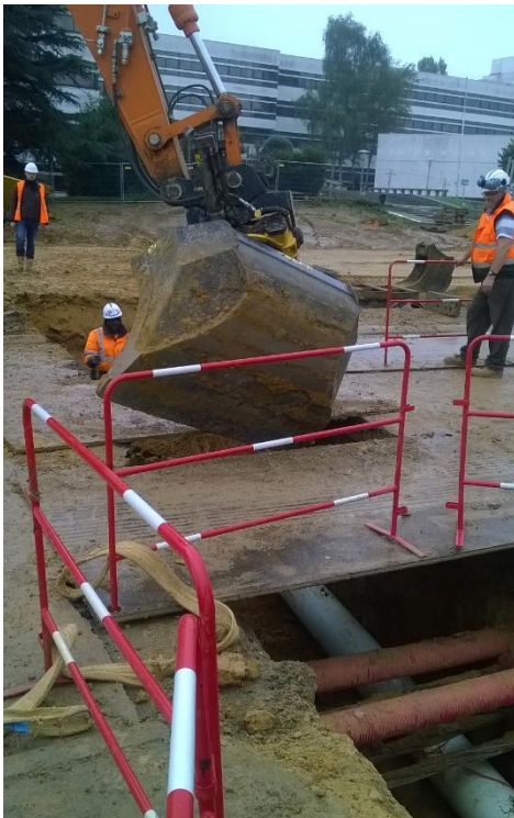
Pont lourd pour circulation engins
