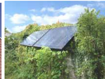
S'il s'avère difficile d'implanter les capteurs en toiture ou en façade (orientation défavorable, surface réduite, intérêt architectural à préserver), ils peuvent être isolés de la construction et posés au sol, ou adossés à un mur.
