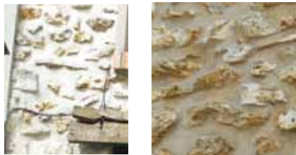
enduit à pierre vue appelé aussi enduit beurré à fleur
