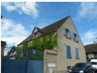
exemple d'enduit couvrant
