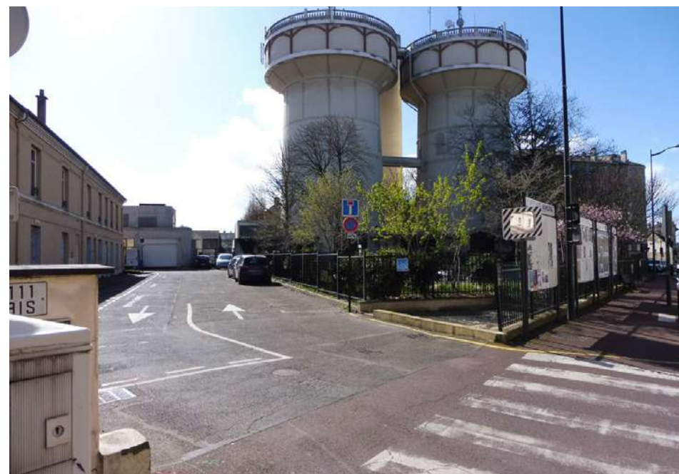
CHÂTEAUX D'EAU EXISTANTS- UN PATRIMOINE SOUS-CONSIDÉRÉ
