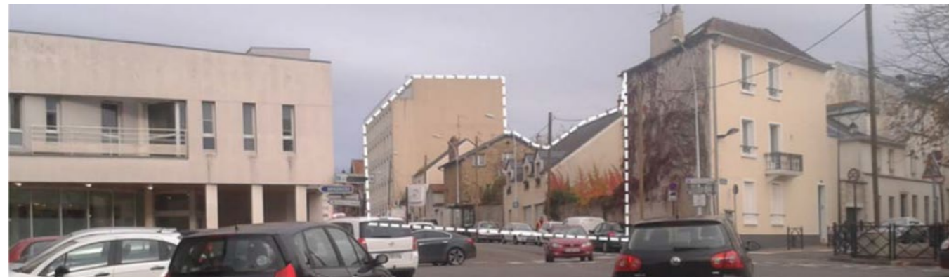
Un manque de cohérence des formes urbaines au sein et à proximité du site de l'hôpital – Source : Etude urbaine ICADE
