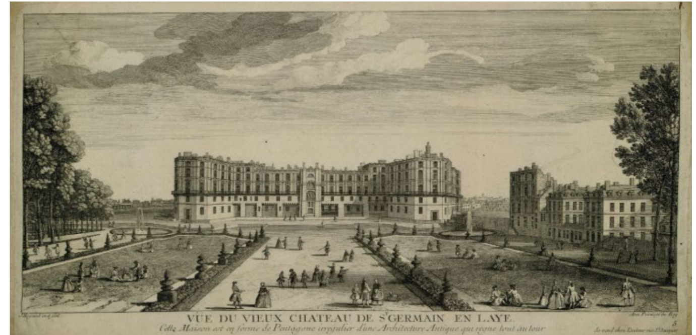
Un château qui a fait et fait encore aujourd'hui la renommée de la commune – Source : Commune de Saint-Germain-en-Laye
