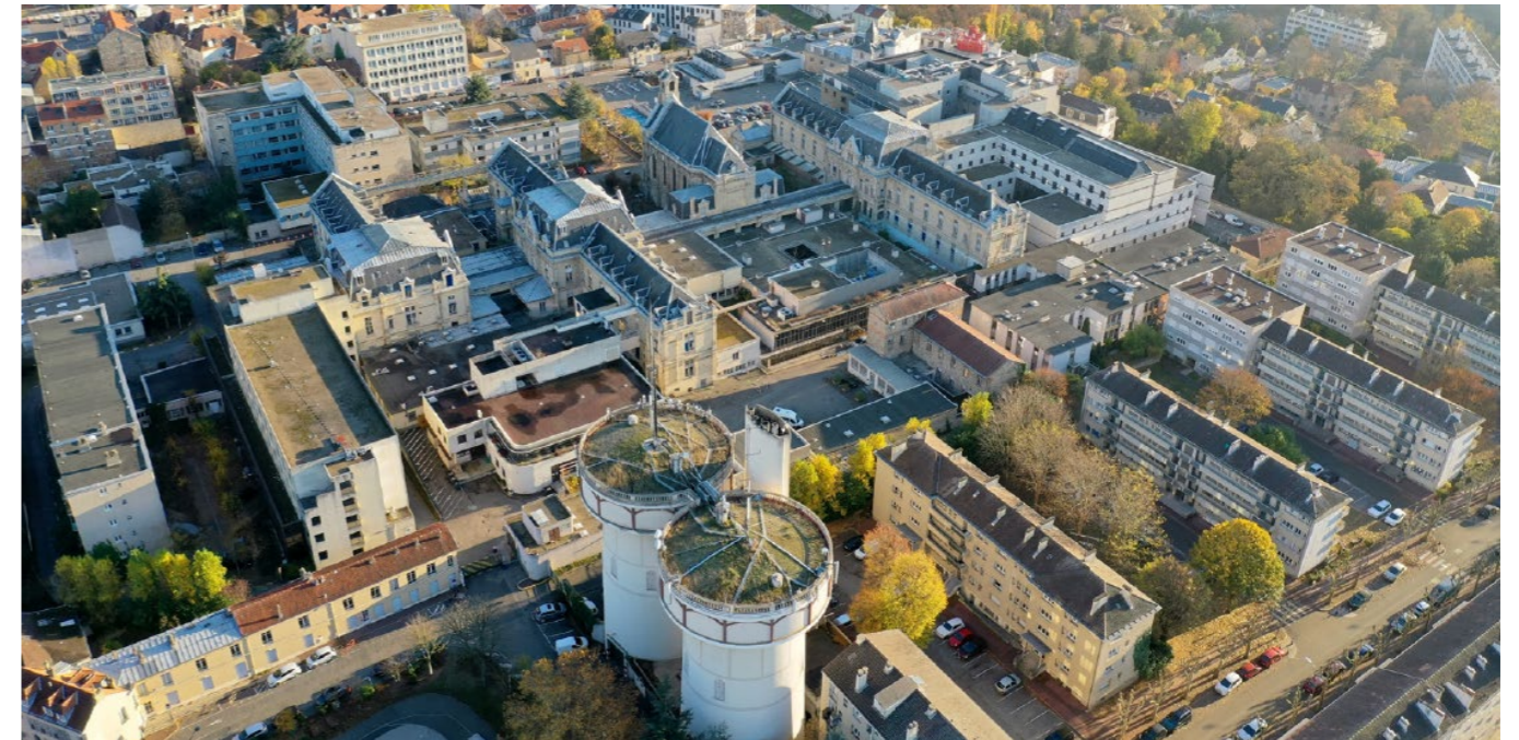
Les pavillons Gérard et Lamant, des édifices d'intérêt patrimonial au cœur du site de projet – Source : Commune de Saint-Germain-en-Laye
