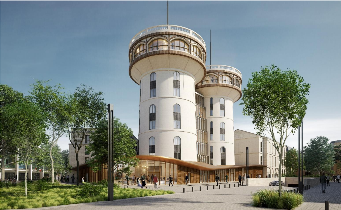
Une porte sur le centre-ville renouvelée, avec des éléments signaux revalorisés qui donnent une image attractive et moderne à la commune – Source : Groupement OGIC / MARIGNAN / SODES / ORPEA
