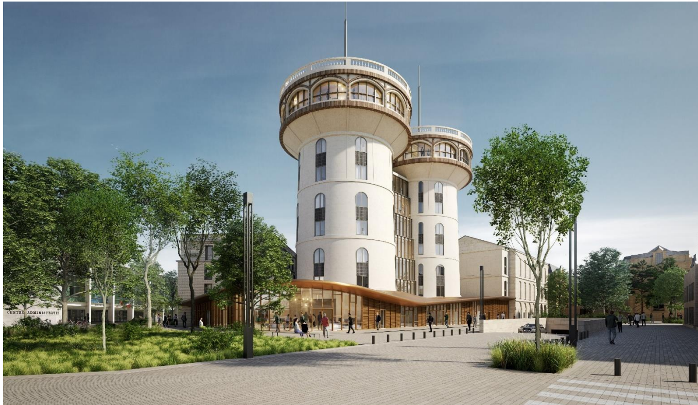
Une valorisation architecturale et fonctionnelle des châteaux d'eau, soulignée par les nouvelles constructions modernes – Source : OGIC
