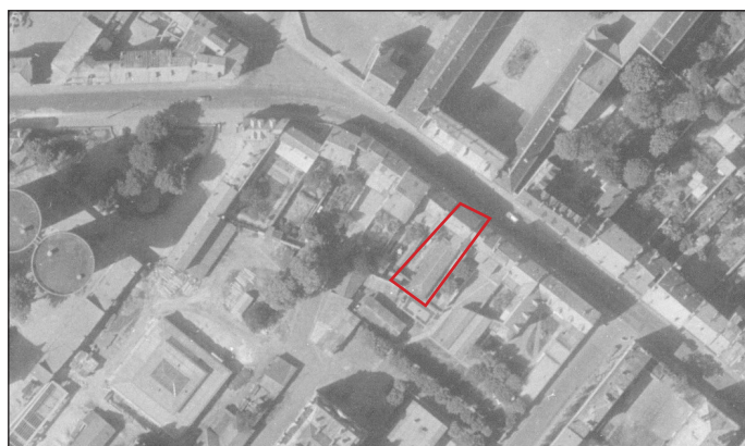
Vue aérienne de 1956 montrant le bâtiment en retour en aile à l'arrière de l'édifice
