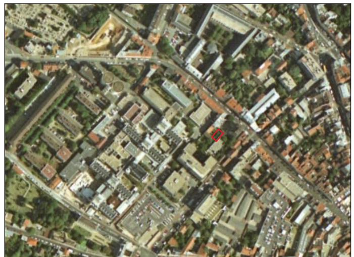
Vue aérienne de 1993 où l'on voit le bâtiment construit.
