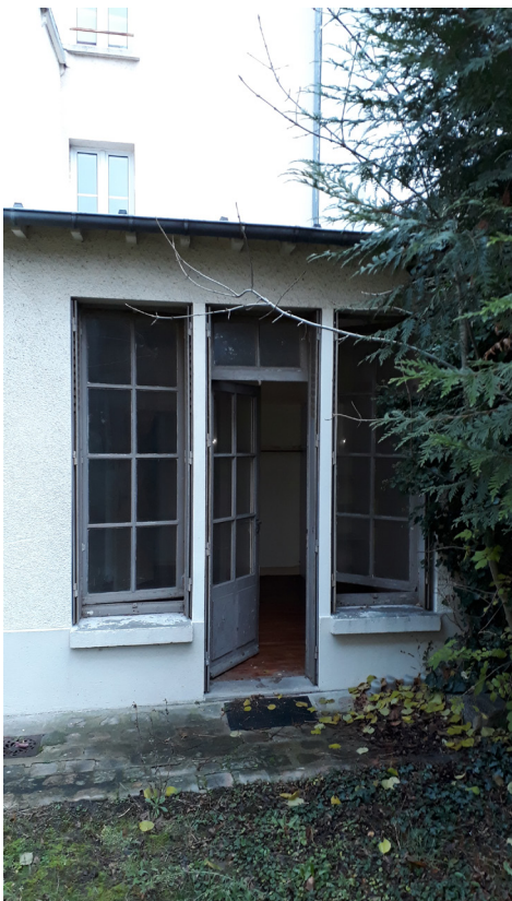
Vue de l'ensemble menuisé en extension sur jardin
