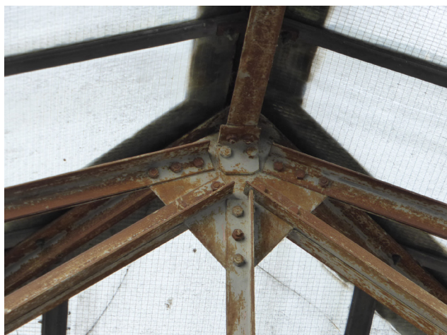
Détail assemblage d'une ferme
