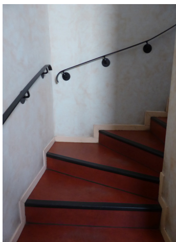
Vues générales de l'escalier
