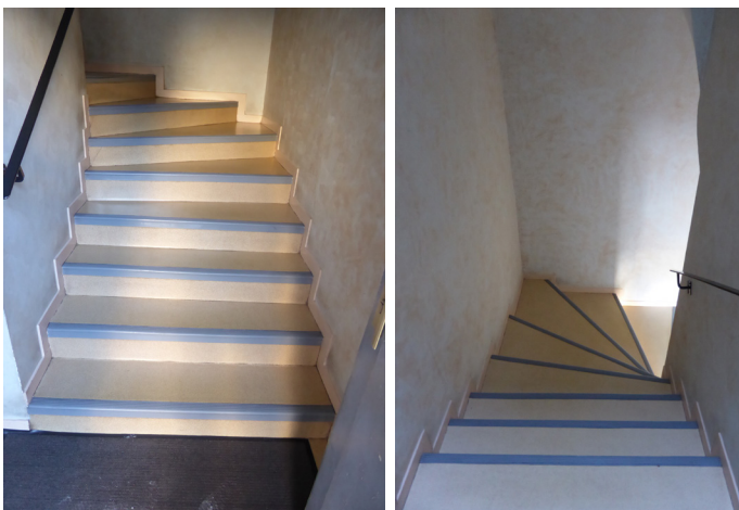
Vues générales de l'escalier
