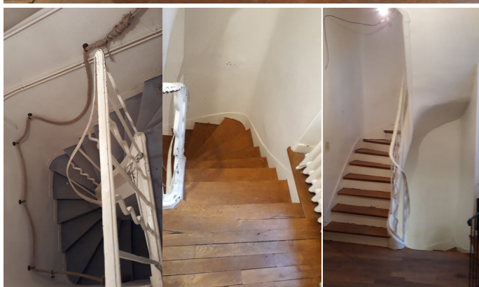
Vues générales de l'escalier
