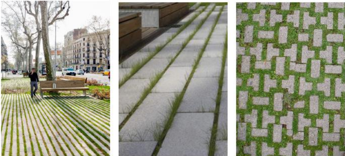
Exemples de revêtements poreux envisagés – Source : OGIC
