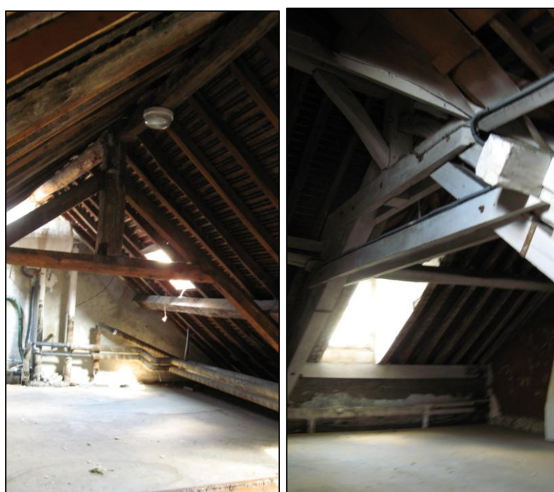
Charpentes à éléments doublés et reprises modernes caractérisent les combles de ces bâtis.
