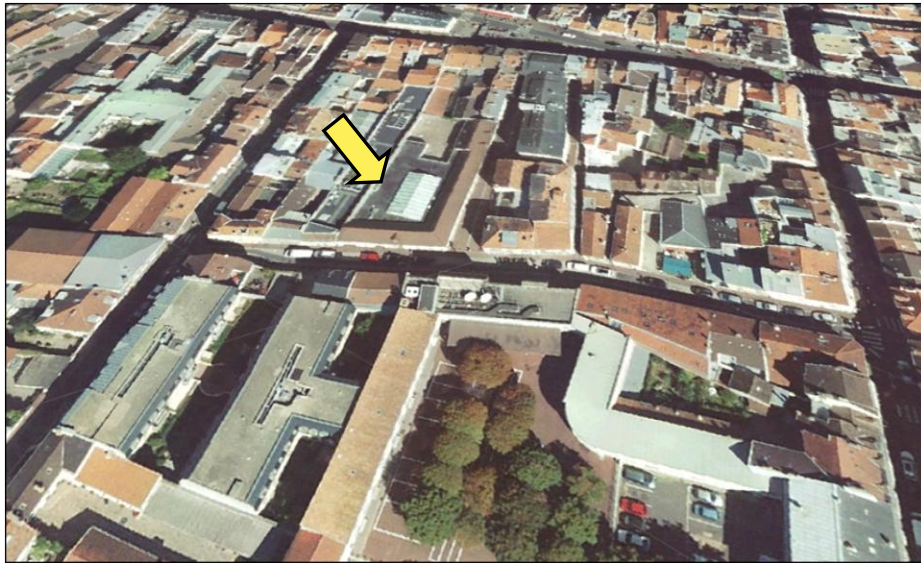
Vue aérienne de l'emplacement de la parcelle faisant angle entre la rue des Joueries et la cour des Syrènes
