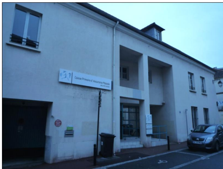
Bâtiment de la Caisse Primaire d'Assurance Maladie- Vue depuis la rue des Joueries
