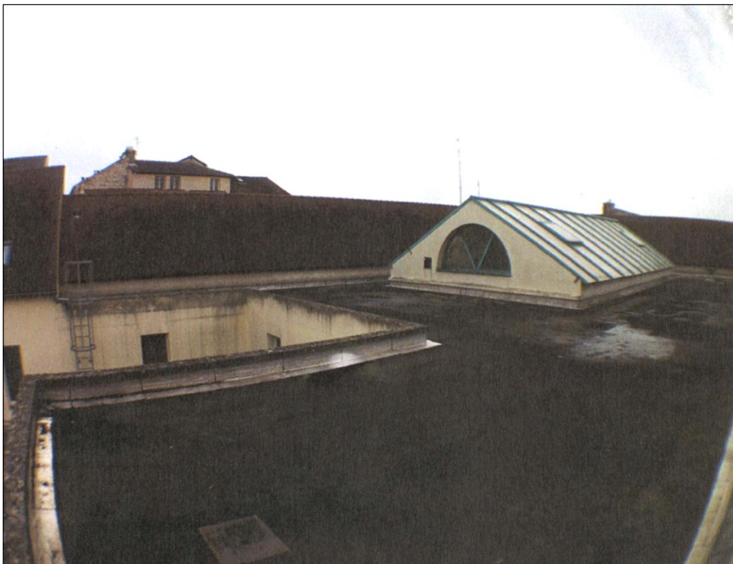
Vue vers le nord-est des « couvertures » des bâtiments secondaires en intérieur de parcelle.
