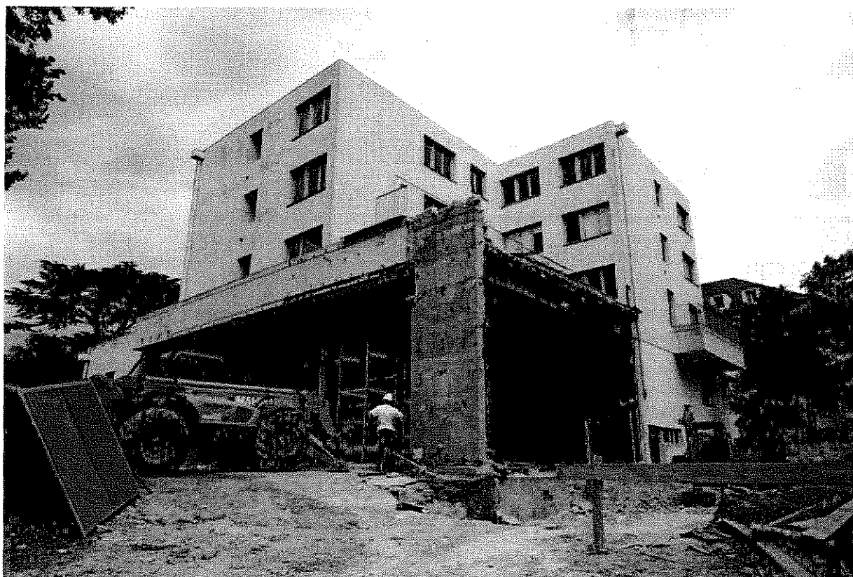
le Chantier de La Clef
