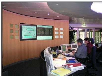
La totalité des ouvrages de production et de transport est entièrement automatisée et pilotée 24 heures sur 24 par un centre de télécontrôle régional basé au Pecq. Le centre de télécontrôle (ou dispatching), est équipé des technologies les plus récentes dans le domaine des télécommunications et permet de surveiller le remplissage des réservoirs et d'ajuster la production de manière à garantir la continuité de la distribution d'eau potable sur l'ensemble des communes de la Région.
