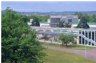
Usine de production d'eau potable de Flins-Aubergenville
