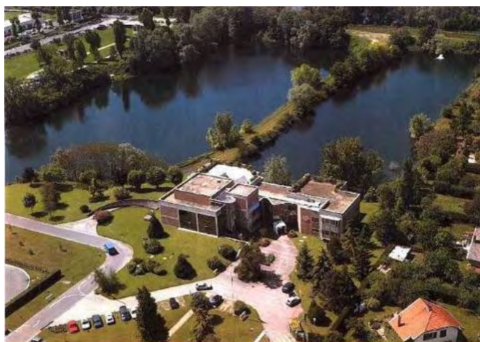
Vue aérienne du bâtiment des services support et du télécontrôle au Pecq
