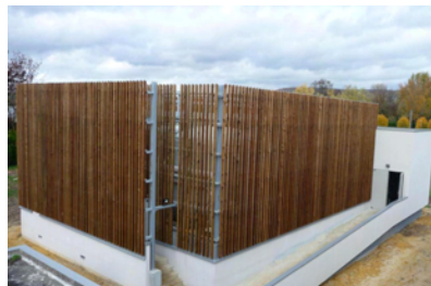
Usine de production d'eau potable de Vernouillet
