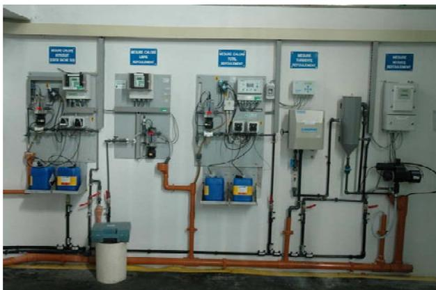
**L'analyse en continu:** un contrôle 24h/24 des paramètres de la qualité de l'eau sur les eaux en sortie des usines d'eau potable. Conforme aux critères de qualité, l'eau est ensuite pompée vers les réservoirs avant d'être distribuée.
