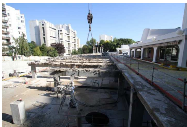
Démolition de la place
