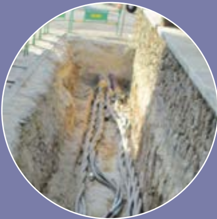
Travaux d'enfouissement Rue Descartes - Plaisir.
