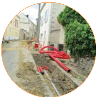
Travaux d'enfouissement, rue des Thuret Oinville sur Montcient.
