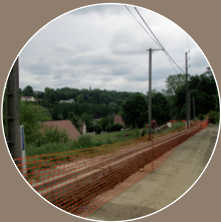
Travaux d'enfouissement à Oinville sur Montcient
