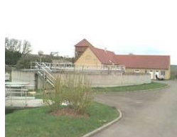
Station d'épuration du Syndicat Intercommunal d'Assainissement de Thiverval- Feucherolles-Chavenay
