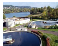
Station d'épuration du Syndicat Intercommunal d'Eau et d'Assainissement de Verneuil-Vernouillet
