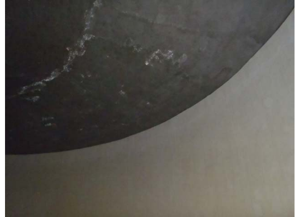
Vue intérieure réservoir
