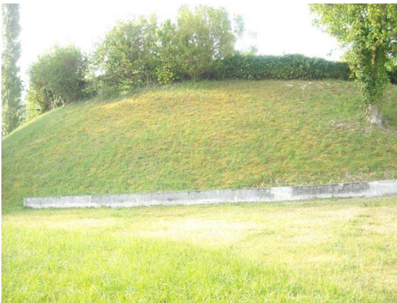
Vue extérieure réservoir
