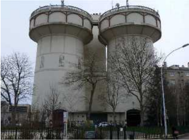
Vue extérieure réservoir
