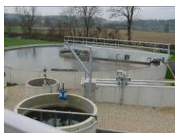
Station d'épuration de la Communauté d'Agglomération des Portes de l'Eure (Pacy-sur-Eure)
