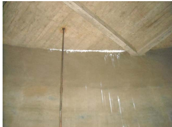
Vue intérieure réservoir
