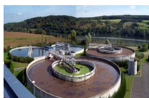
Station d'épuration de la Communauté d'Agglomération des Portes de l'Eure (Vernon)
