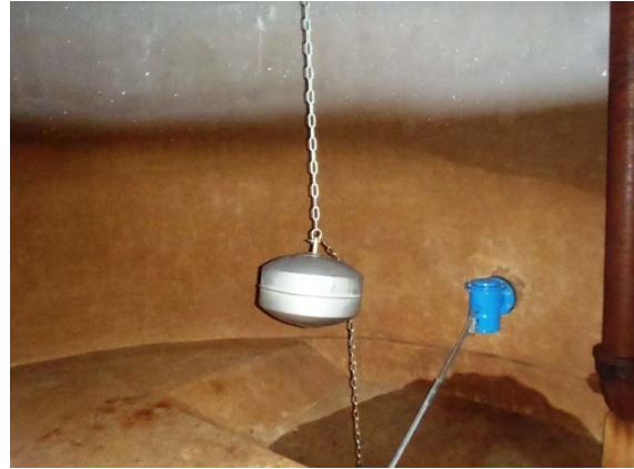
Vue intérieure réservoir
