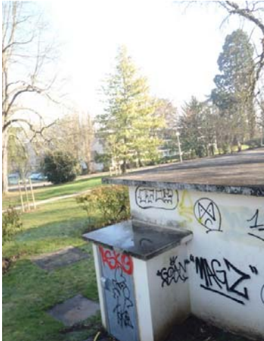
Vue extérieure réservoir
