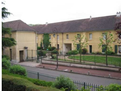
Les Tanneries Royales, aujourd'hui transformées en logements
