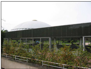
La piscine municipale de St Germain, construite dans le style International dans les années 70, semble rendre hommage à l'architecture d'Oscar Niemeyer
