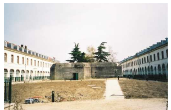
Un centre-ville qui se renouvelle: transformation de la caserne Gramont en logements.
