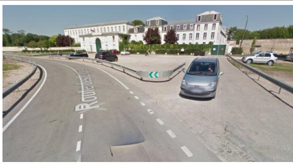
Création d'un arrêt sur le parking de la MELH
